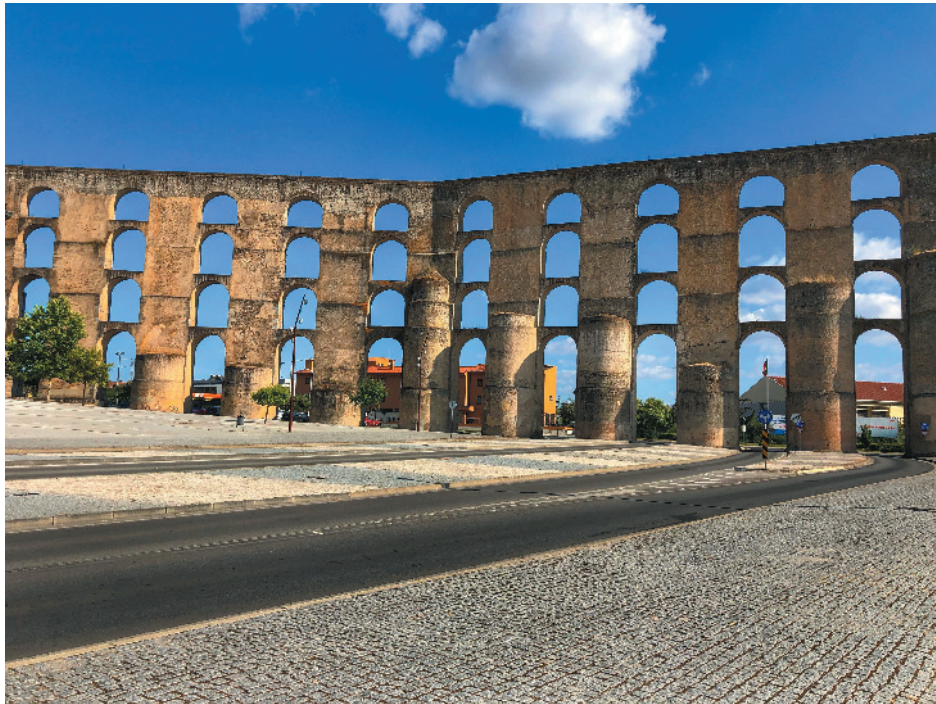
Aqueduto de Elvas
