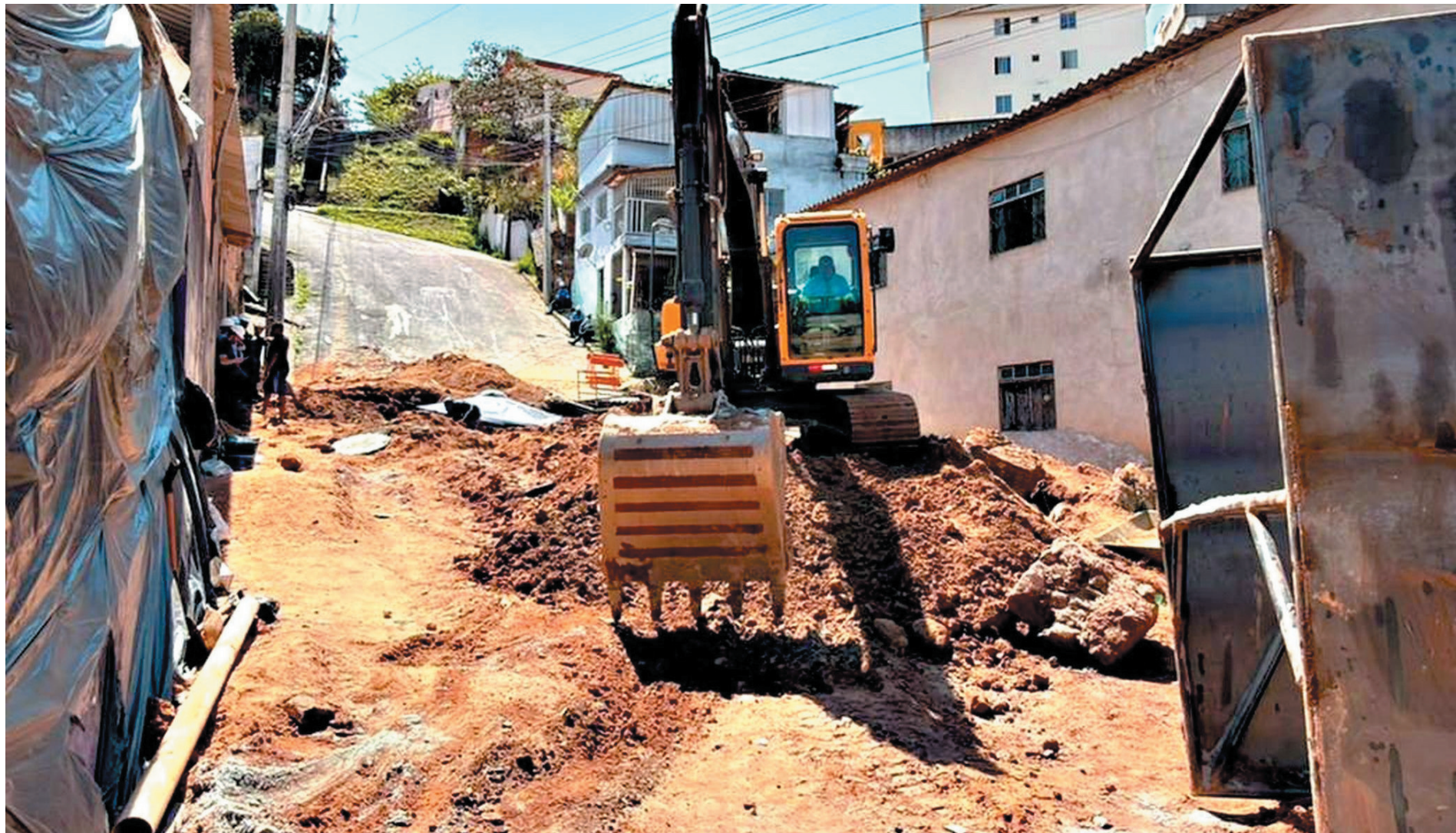
Em 5 de setembro, Copasa concluiu obra no bairro Nova Granada; 40 bairros tiveram o abastecimento de água prejudicado devido ao rompimento da adutora, em 19 de agosto
