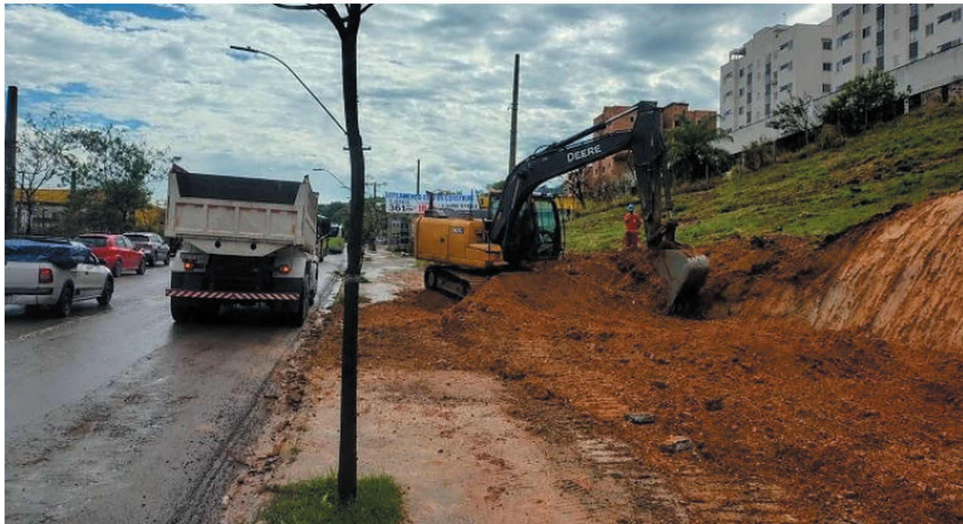
A nova faixa vai começar logo abaixo do pontilhão do metrô, à frente da estação Primeiro de Maio. Vai se estender até a junção com a Waldomiro Lobo, no bairro Guarani
