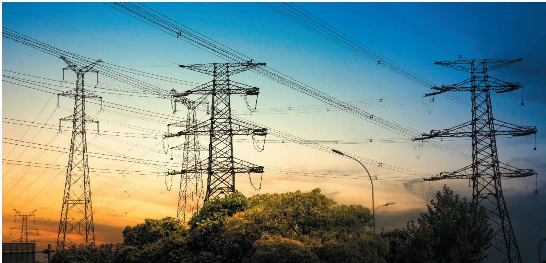
Para a Fiemg, cenário preocupa porque o sistema elétrico brasileiro já opera com acionamento de usinas termelétricas, consideradas mais caras
